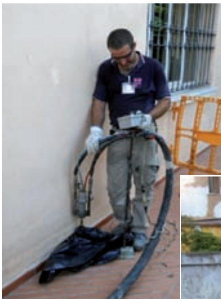
Foto a sinistra: esecuzione prova penetrometrica a consolidamento avvenuto Foto in basso: iniezione di resina
