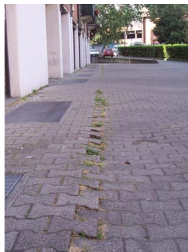
Masselli posati senza adeguato costipamento del sottofondo
