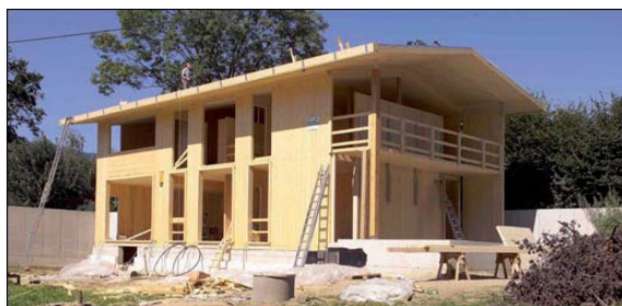
Vista esterna di una casa E-wall in costruzione
